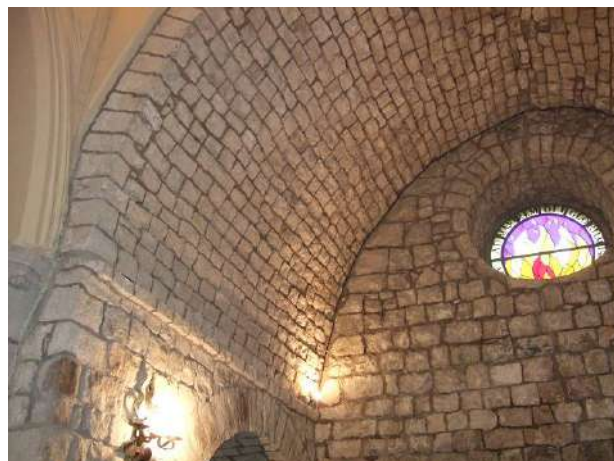
On aperçoit encore la pierre en saillie qui supportait la tribune
